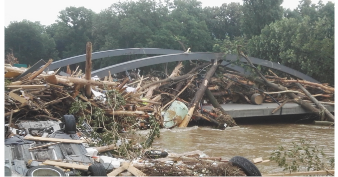
Zerstörte Brücke in Bad Neuenahr, Quelle: J. Bogárdi
