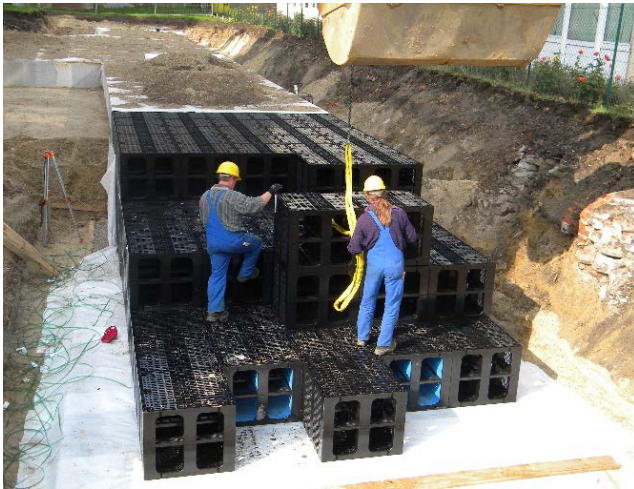
Abb. 3: NW-Versickerung mit RAUSIKKO®-Boxen
