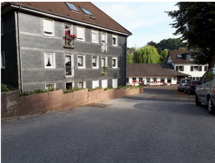
Abb. 11: Umgesetzte Schutzmaßnahmen am Pilgerheim Weltersbach
