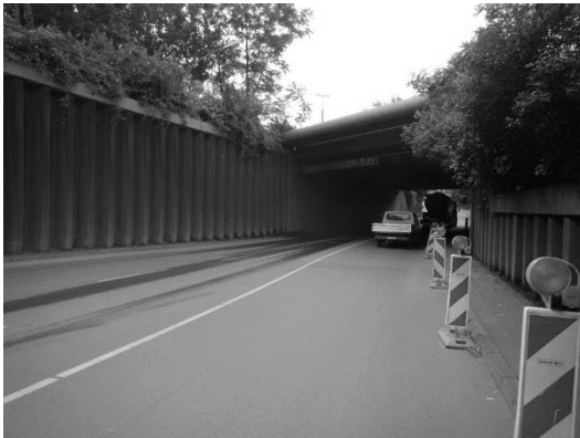
Abb. 3: Straßenunterführungen als potenzielle Bereiche hohen Risikos
