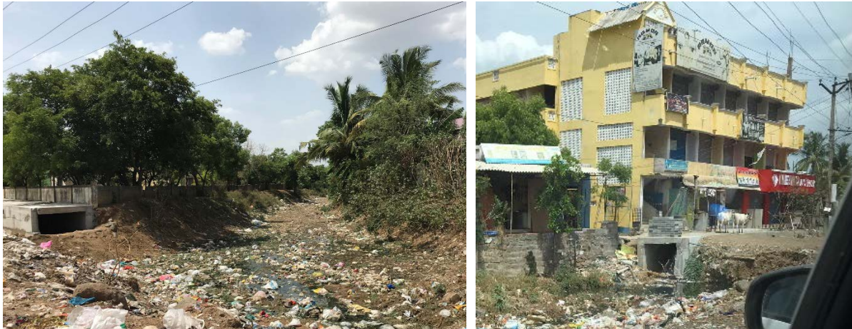
Abb. 5: Müllproblematik in Chennai- Entwässerungsanlagen sind zum Teil komplett verklaust Quelle: C. Pohl - DHI
