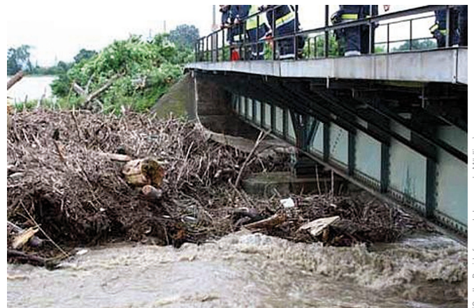
Bild 13 Verklauung an einer Brücke Log jam at a bridge
