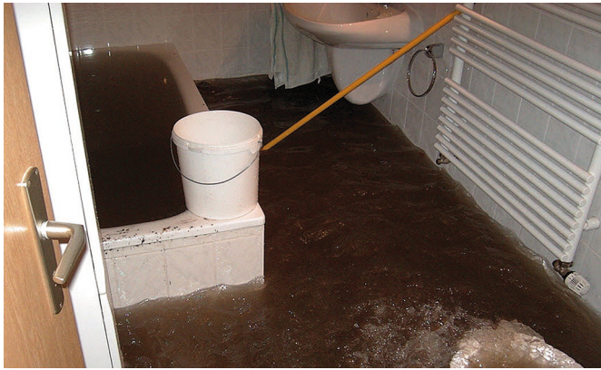
Bild 11 Gebäude-Keller ohne Rückstausicherung Basement without backflow protection
