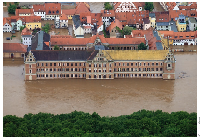
Bild 7 Statische Überschwemmung Static flooding
