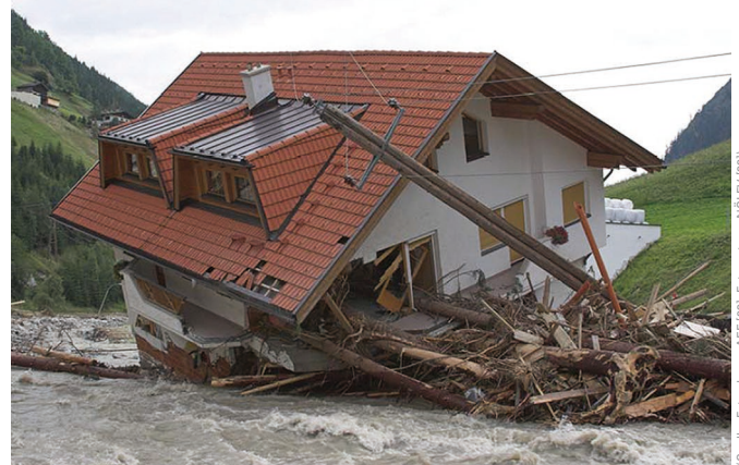
Bild 10 Einsturz eines Gebäudes – Uferabbruch Collapse of a building – torrent slope slide
