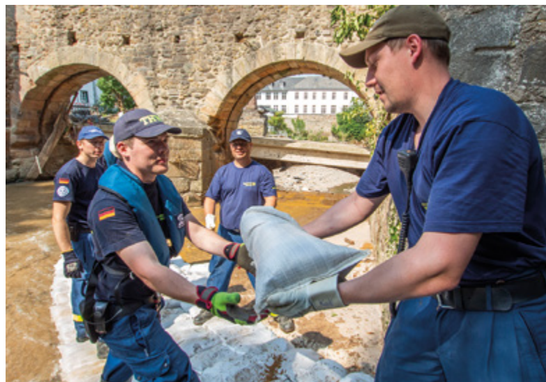
Hand in Hand: Alle 668 THW-Ortsverbände waren zur Bekämpfung der Schadenslage nach der Flutkatastrophe vor Ort. (Foto: THW / Maximilian Christ)
