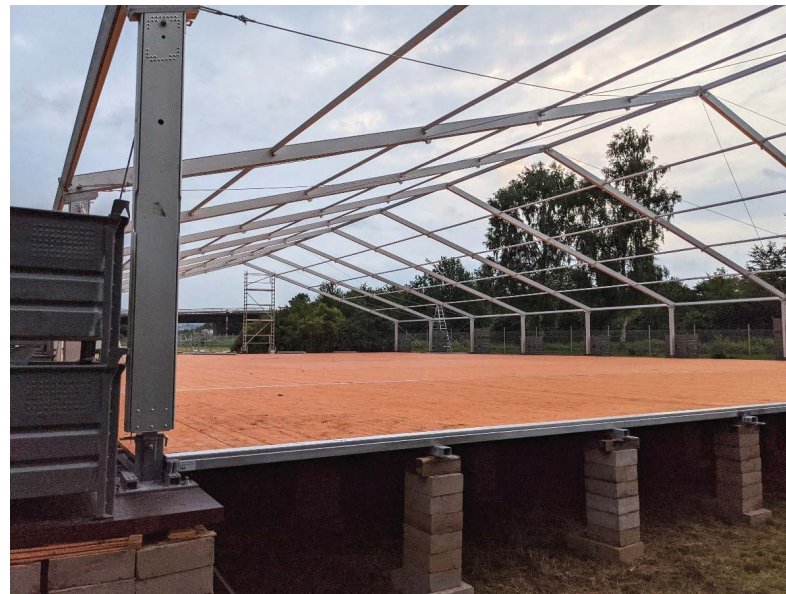
Aufbau Verpflegungszelt in Mendig. (Foto: Machinia / BBK)
