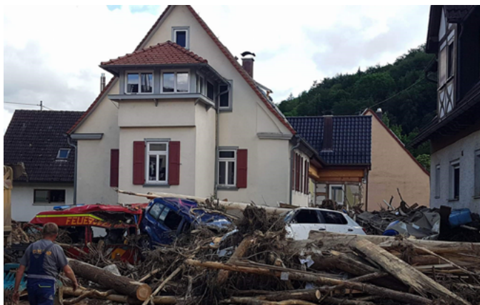
Von einer Sturzflut betroffene Ortschaft (Foto: THW OV Crailsheim)
